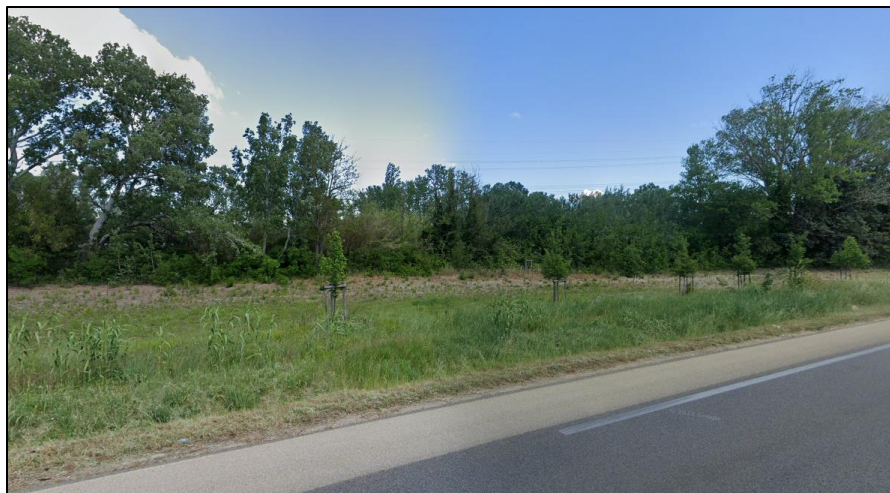
Figure 42. Bassin de rétention bordé de jeunes plantations d'arbres (source : Street View).
