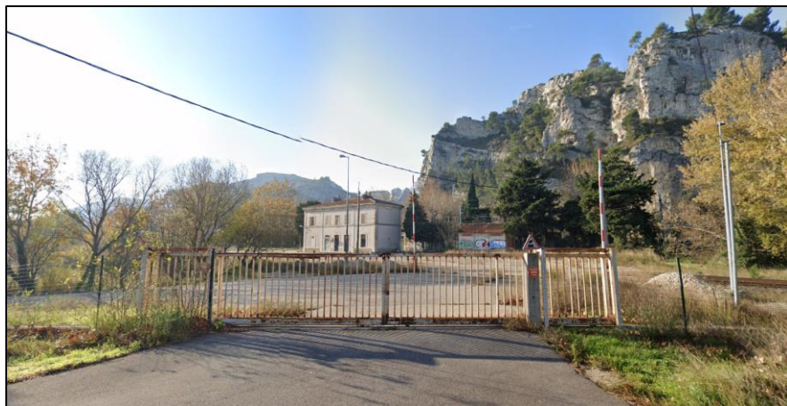
Figure 62. Vue sur la gare depuis la RD 73D (source : Street View).
