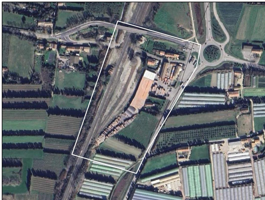
Figure 46. Vue aérienne du projet.
