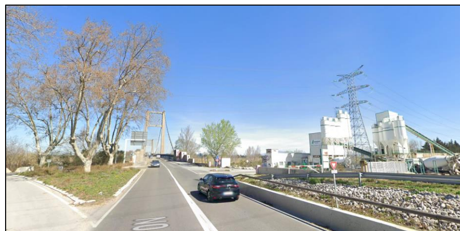
Figure 51. Vue sur l'amont du pont de Rognonas : voirie, platanes et installations de l'entreprise Lafarge (source : Street view).
