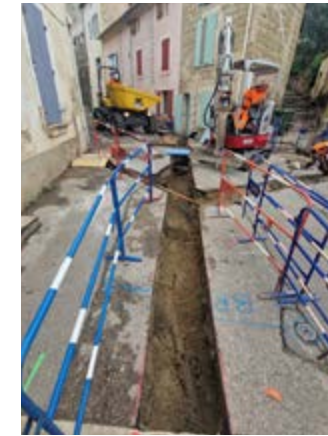
Travaux chemin sous l'Hôpital
