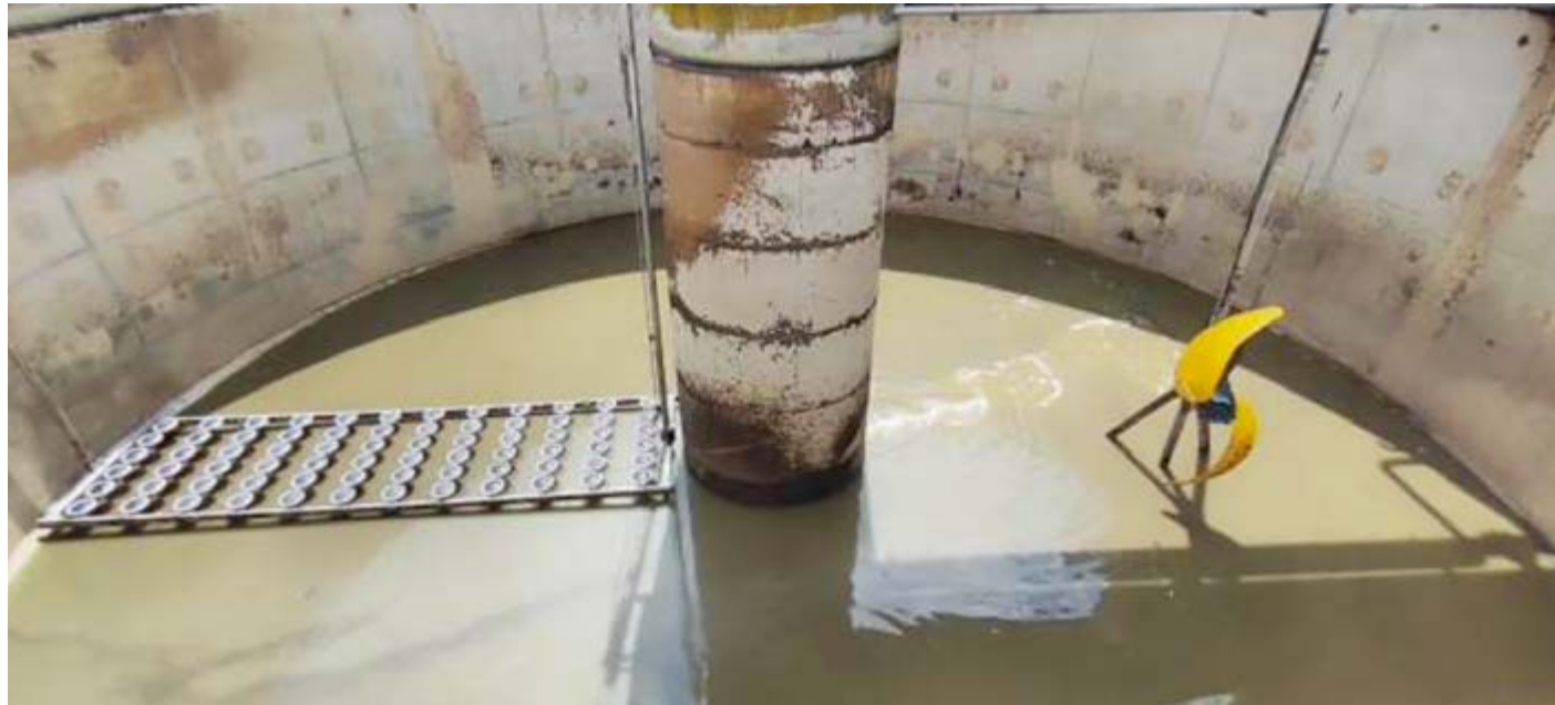
Désensablage du bassin d'aération avec renouvellement des diffuseurs d'air
