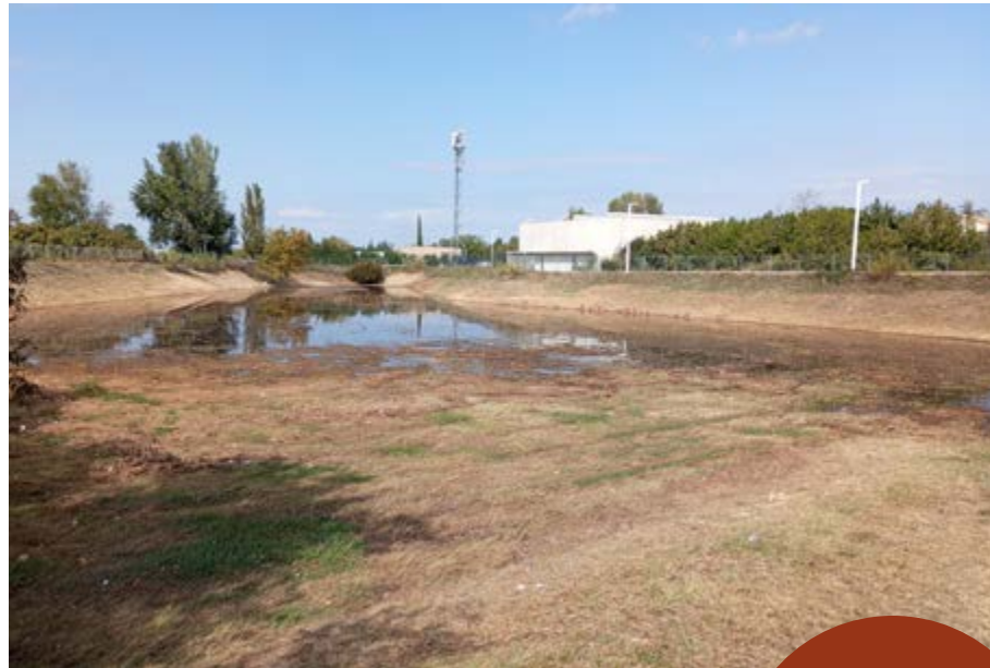
Bassin de rétention après entretien - Châteaurenard
