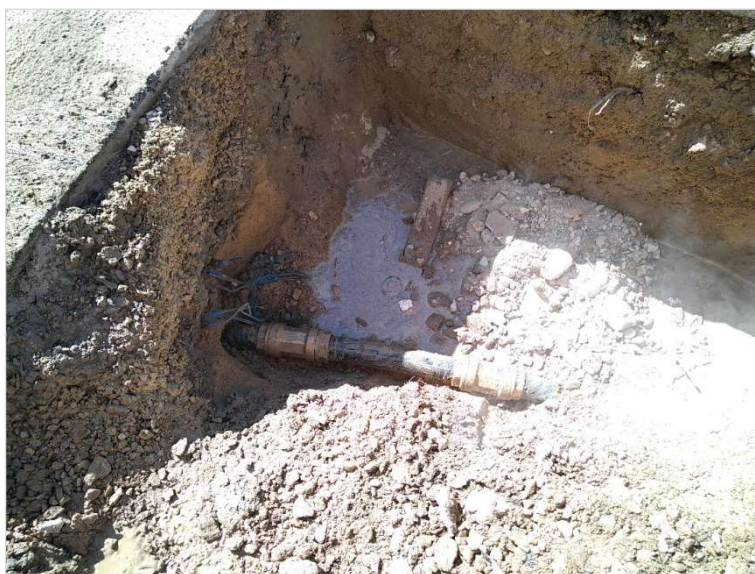
Le 15 juin 2021 : réparation d'une conduite en PEHD DN 63 par la pose de 2 manchons ISIFLO.
