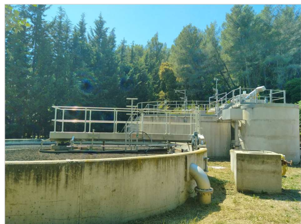
La station d'épuration à Orgon
